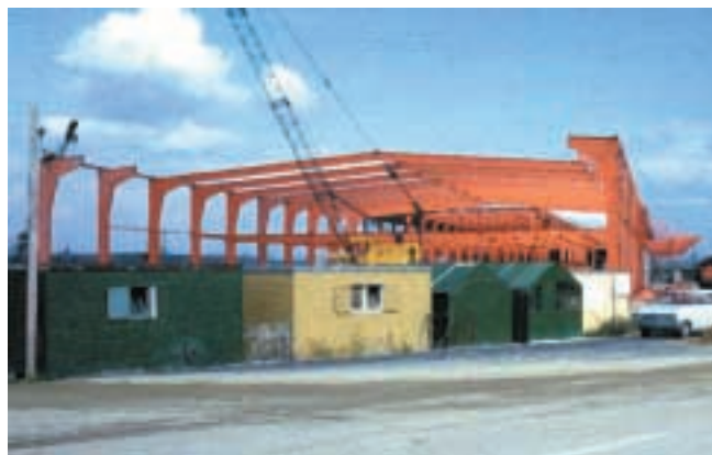
Figure 4 – Montage d'une charpente métallique par grue mobile sur pneus
