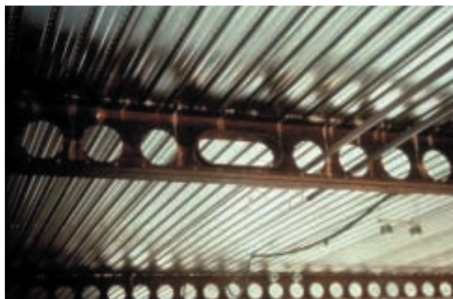
Figure 5 – Réalisation d'un plancher « bac acier » sur poutrelles alvéolaires
